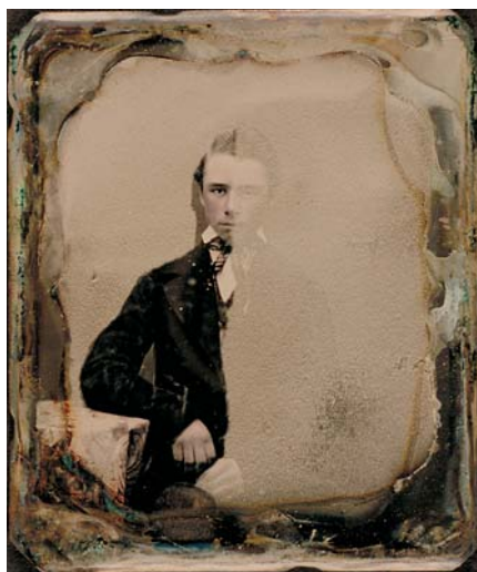
PROCESO DE RESTAURACIÓN
